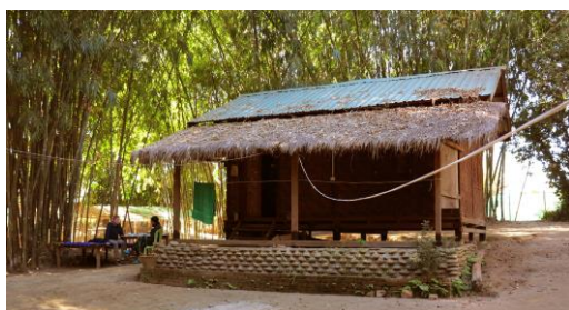
Een van de zelfgebouwde schoolgebouwen
